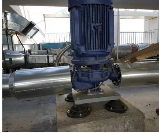
电机设备橡胶基座减振
